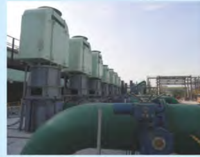
宁夏石油500万吨炼油改扩建工程 Sinopec Ningxia 5,000,000 Ton Oil Project
