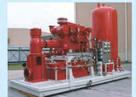
尼日尔Agadem油田一体化项目 Agadem Oil Field Integration Project in Niger
